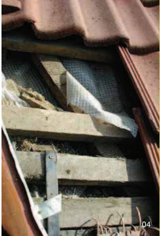
04 | Vadně provedená doplňková hydroizolační vrstva 05 | Hotel Olympic v Praze v zimě roku 2000, na nižší střechě pod okny ubytovací části leží předměty vyhozené okem
