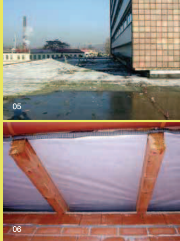
06 | Kondenzát stékající po doplňkové hydroizolační vrstvě 07 | Úžlabí kryté bobrovkou Obr. 01 | Řez krytinou MAXIDEK s úhlovými kótami
