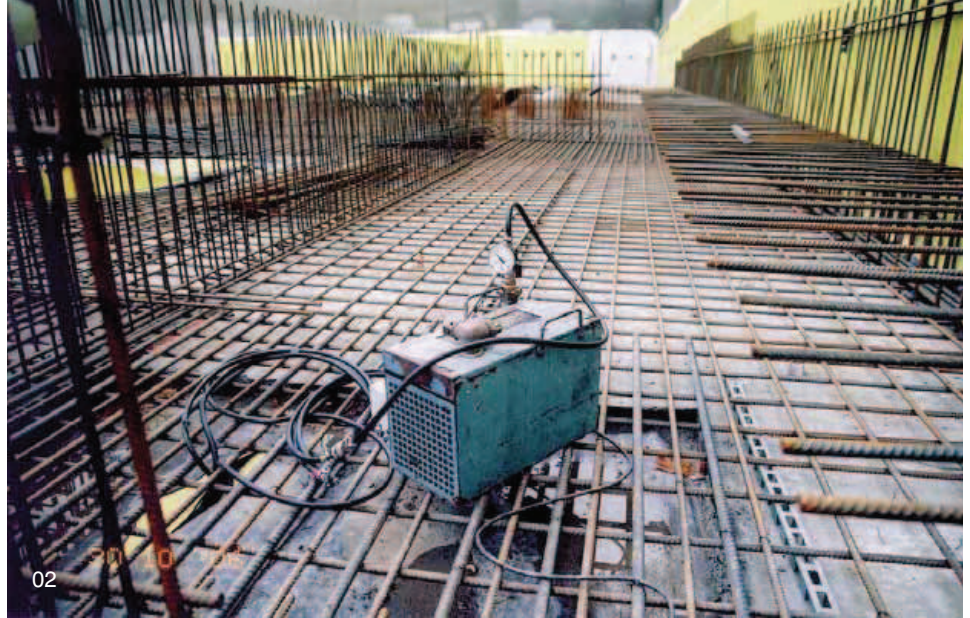
02-03 | Vakuová zkouška těsnosti sektoru hydroizolace zakrytého dokončenou výztuží
